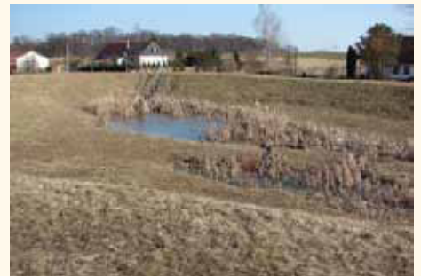
Abb. 3 und 4: Naturnah angelegtes Regenrückhaltebecken
