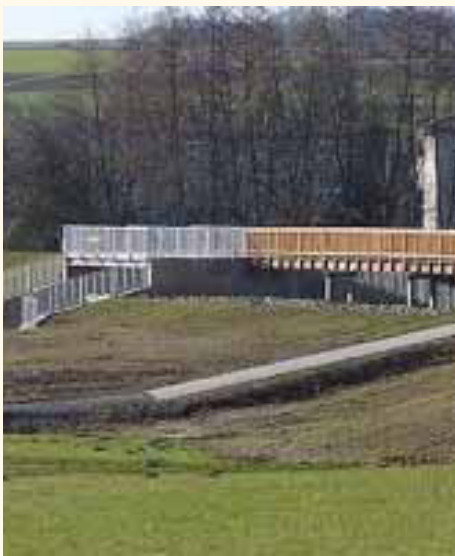
Abb. 2: Damm mit Auslaufbauwerk
