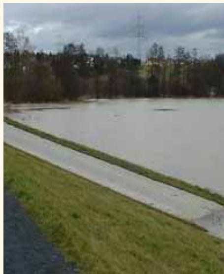
Abb. 3: Becken im Einstau I
