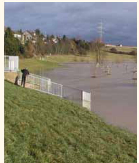
Abb. 4: Becken im Einstau II
