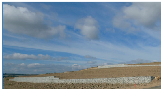
Abb. 3: Neu gebaute Weinbergsmauern
