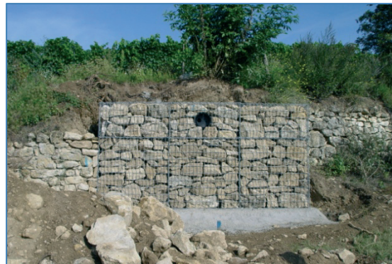
Abb. 2: Mauersanierung und -freistellung
