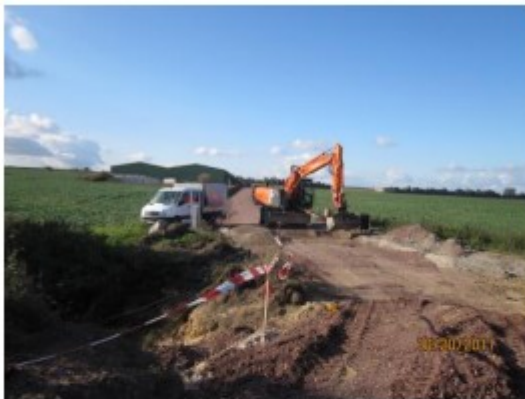
Einbau von Frostschutz und Tragschichten
