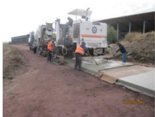
Einsatz Gleitschalungsfertiger
