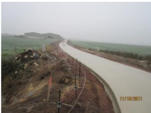
Einbau Spurbahn erfolgreich abgeschlossen
