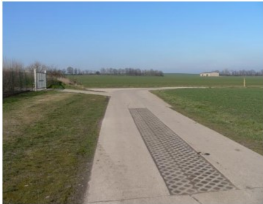
Bauende im Jahr 2022 – guter Erhaltungszustand
