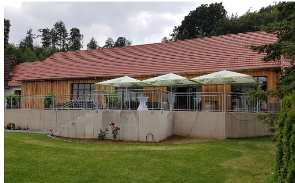
Blick auf die Außenterrasse (Bild: Bezirksregierung Detmold)
