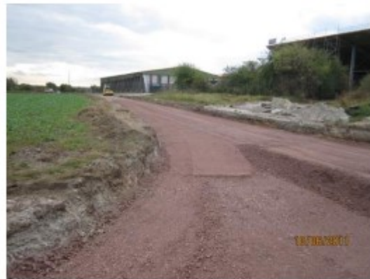
Lageweise Verdichtung - bis 0,80m Einbaustärke
