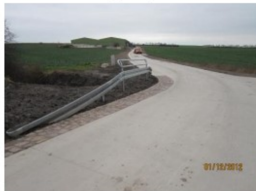
Fertigstellung der Nebenanlagen
