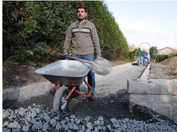
Mitarbeit im Bauhof Aidhausen
