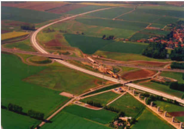
Abb. 1: Kreuzungsbauwerk A 71/ A 4 – ICE Neubaustrecke
