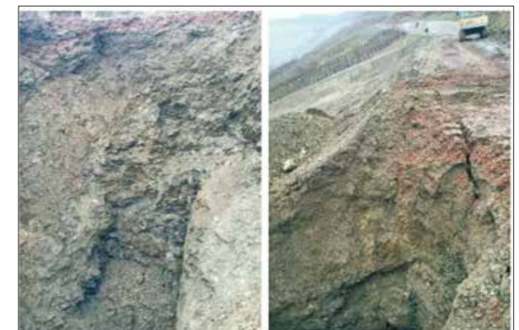
Abb. 14: Linkes Bild: Baggerschurf Stützscheibe Nr. 11, Rechtes Bild: Abriss am oberen Weg
