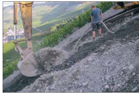
Abb. 8: Zugabe des Bindemittels
