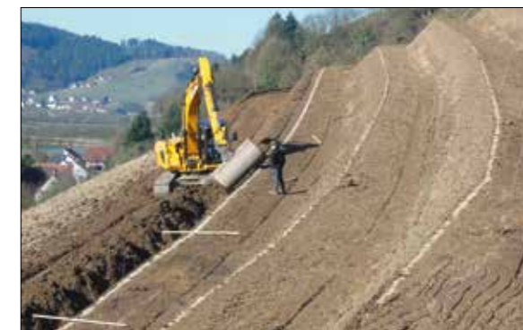
Abb. 7: Abziehen Böschung mit Hilfe des Baggers
