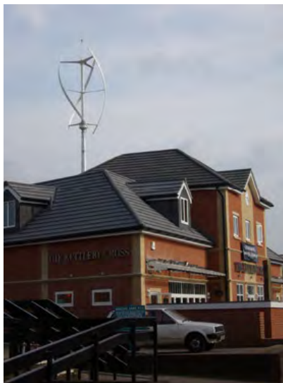
Abbildung 5.1-2: Vertikale Windenergieanlage auf Gebäude [Internet: quietrevolution, Stand: 09.03.2009]
