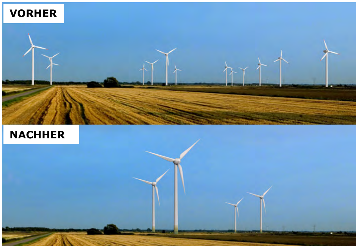
Abbildung 2.1-5: Windpark Hemme (Mecklenburg-Vorpommern), vor und nach dem Repowering [Internet: Bundesverband WindEnergie, Stand: 08.02.2009]
