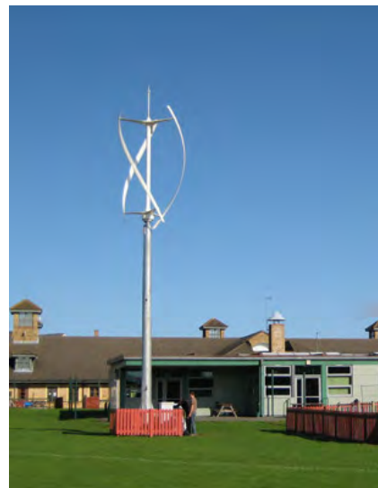
Abbildung 5.1-3: Freistehende vertikale Windenergieanlage [Internet: quietrevolution, Stand: 09.03.2009]
