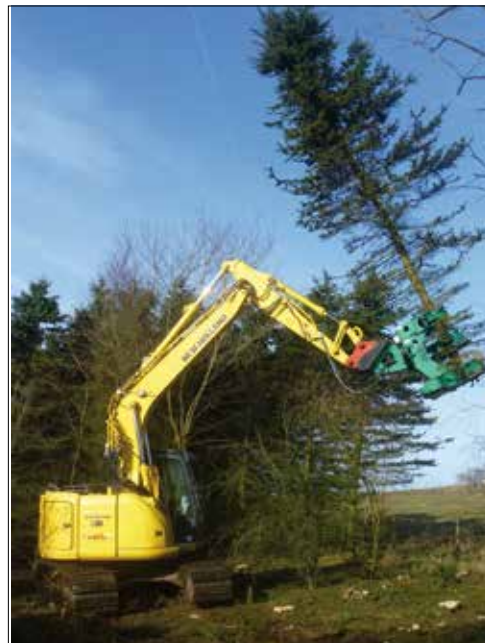
Abb 5: Rodung von Fichtenkulturen – FB-Verfahren Hinterweiler
