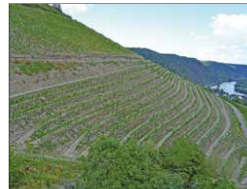
Abb.4: Querterrassen im Moseltal bei Klotten, darüber eine herkömmliche Falllinienbewirtschaftung
