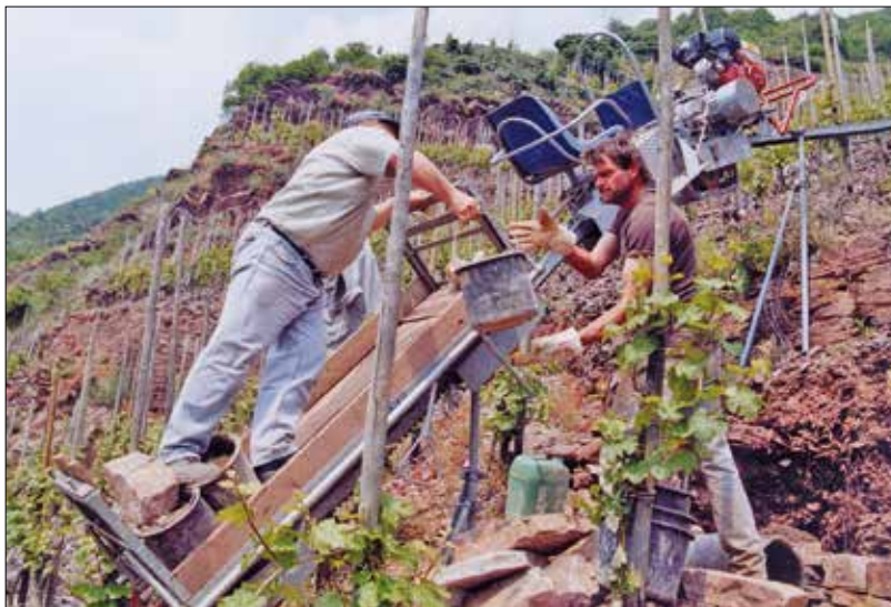
Abb. 5: Für Maueranierungen sind große Massen in den Weinberg zu transportieren (Quelle: Rolf Goergen)
