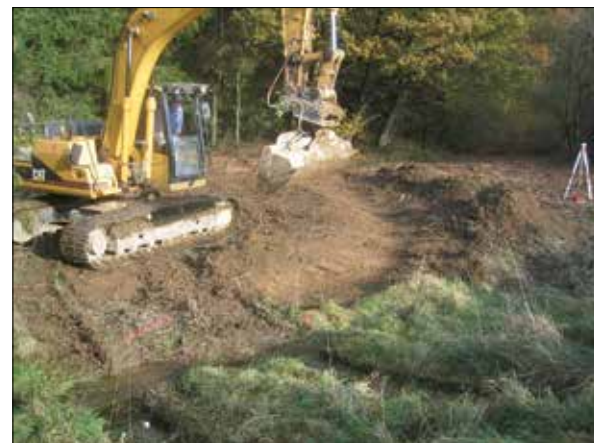
Abb 6: Renaturierung des Sammetbaches am Holzmaar – FB-Verfahren Gillenfeld
