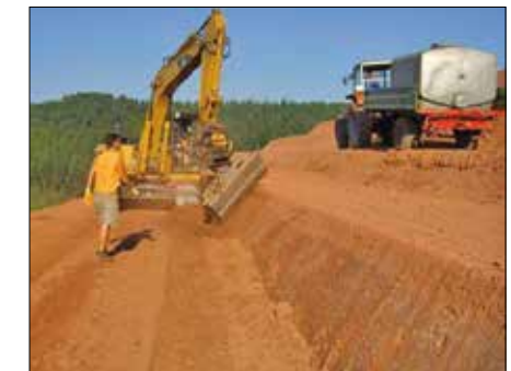
Abb. 6 : Bau von Weinbergsterrassen mit VTG-Baubetrieb
