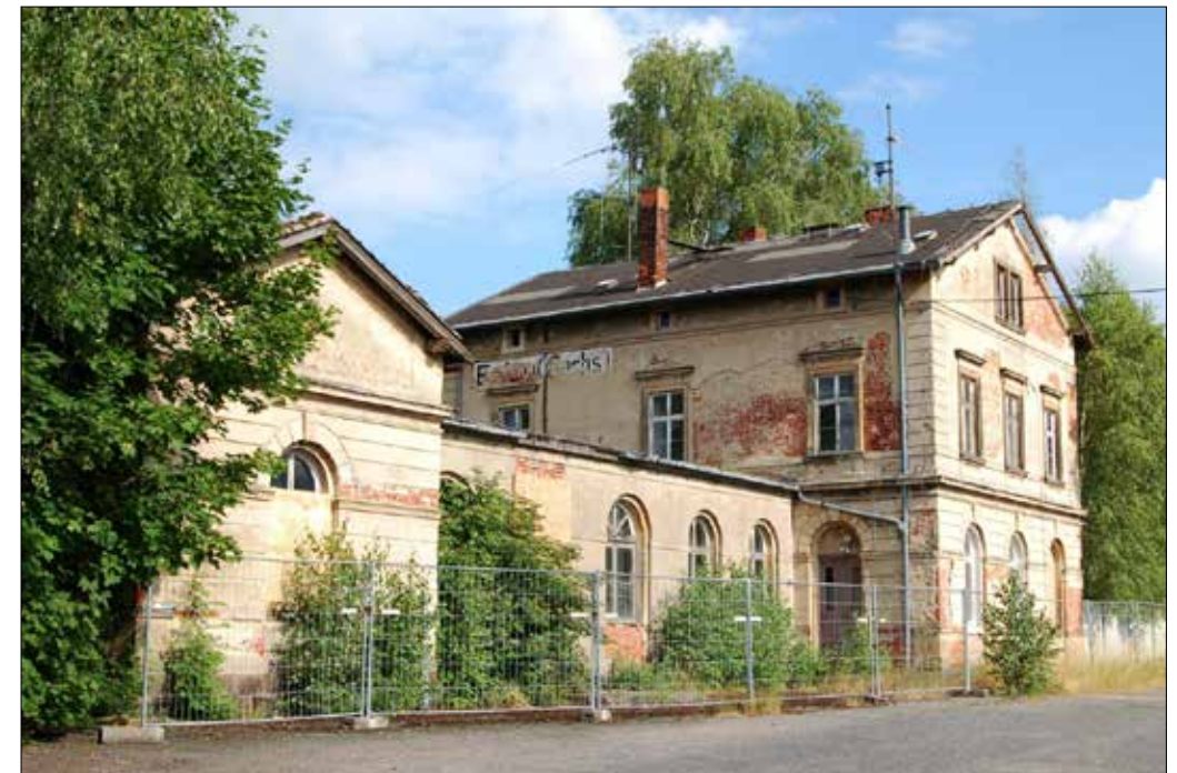
Abb. 1: Der zurzeit ungenutzte Bahnhof Erlau (Sachsen) soll als „Generationenbahnhof“ mehrere neue Funktionen für die Einwohner von Erlau erhalten (Foto: Markus Thieme)
