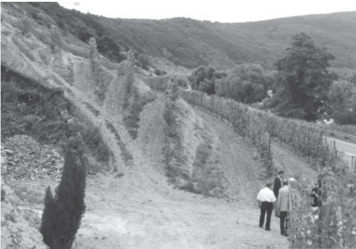
Erhaltung der Weinberge durch Umstellung auf Querterrassierung
