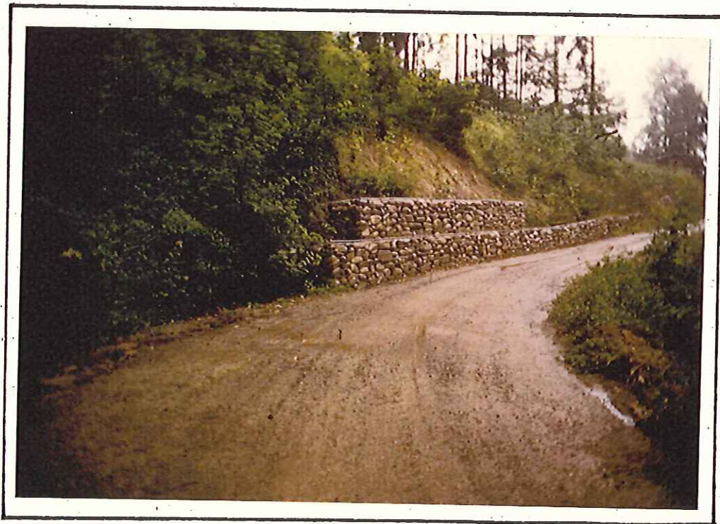
Abb. 53: Verwendung von Drahtschotterkörben
