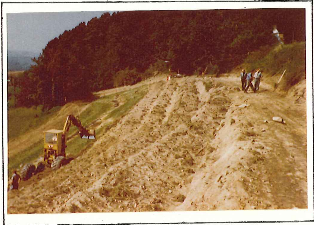
Abb. 27: Herrichtung der Terrasse mit dem Hydraulikbagger Menzi-Muck, der auch im Steilhang mit bis zu 100 % Hangneigung arbeiten kann.
