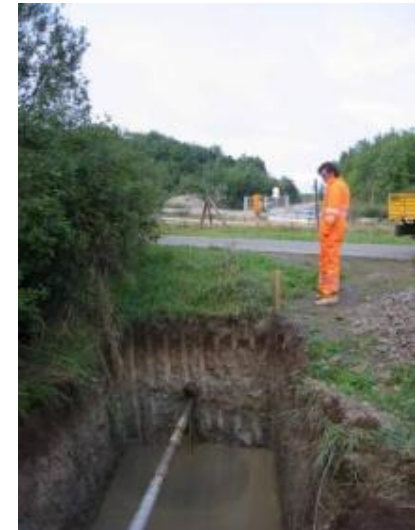
Spülbohrung unter Autobahn
