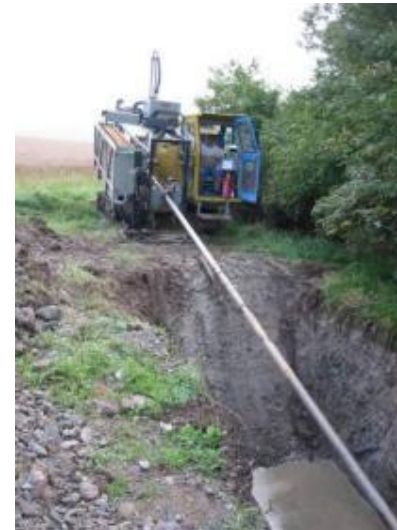
Spülbohrung unter Autobahn
