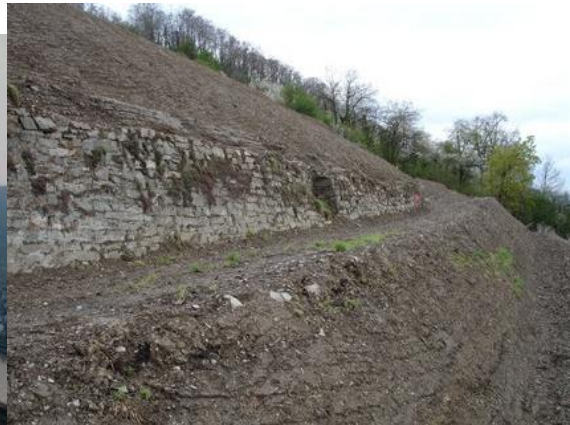
Abbildung 15: integrierte Trockenmauer
