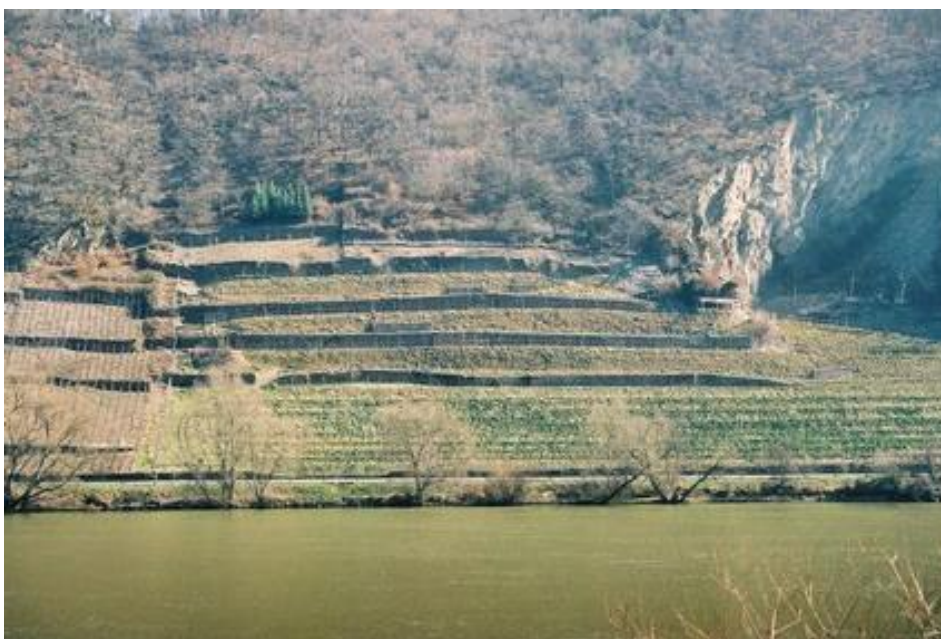
Abbildung 26: Querterrasse in Koblenz-Moselweiß
