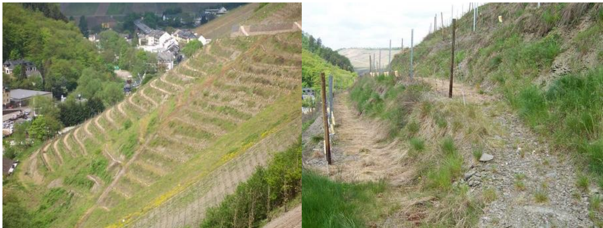
Luftbild einer Querterrassenanlage in Zell (oben), diese Anlage wird mit einer Schmalspurraupe bewirtschaftet; das Ursprungsgelände hat eine Steigung von \sim 70\% ; auf Grund der schlecht angewachsenen Böschung kam es im ersten Jahr zu kleineren Böschungsrutschungen
