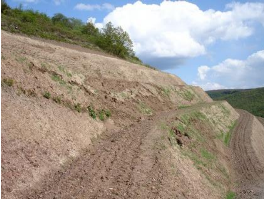
Abbildung 24: Rutschungen durch Bodenfrost
