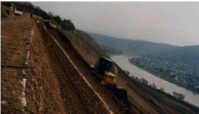
Abbildung 14: Bau von Querterrassen
