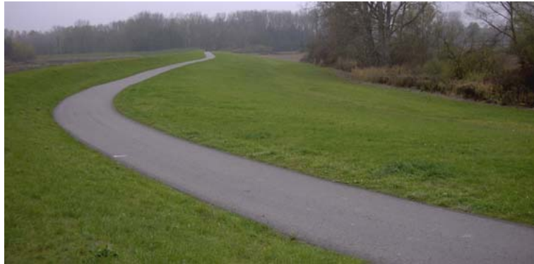
Abbildung 6.23: Bermenweg am neuen Rheinhauptdeich, November 2005
