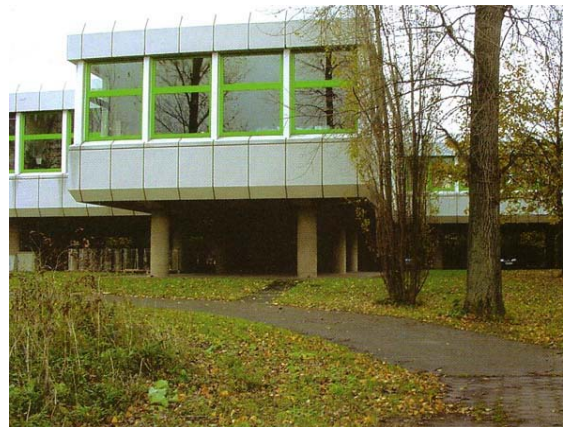
Abbildung 3.7: Angepasste Bauweise in hochwassergefährdetem Gebiet
