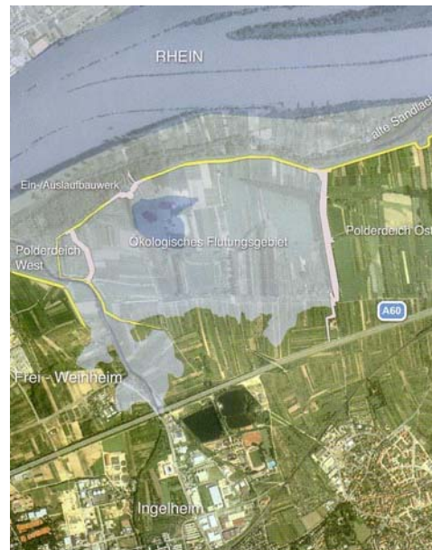
Abbildung 6.37: Gefüllter Polder Ingelheim
