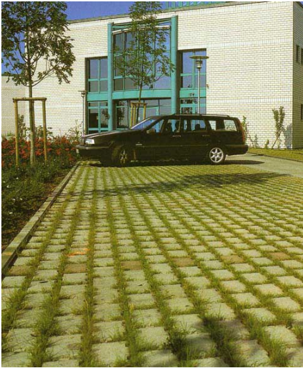
Abbildung 3.3: Parkplatz mit Rasengittersteinen
