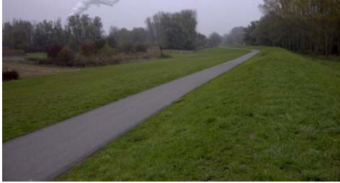
Abbildung 3.5: Deich in Sondernheim, November 2005
