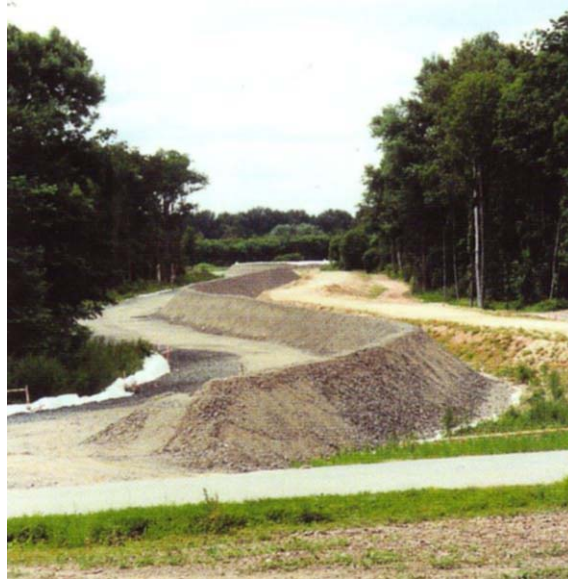
Abbildung 6.56: Einbau des Deichmaterials
