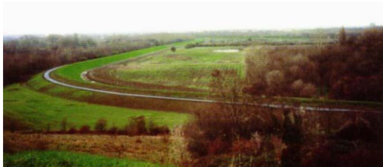
Abbildung 6.54: Blick auf die Retentionsfläche Worms „Bürgerweide“
