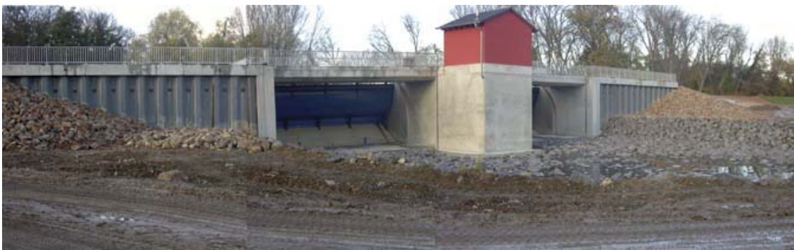
Abbildung 6.39: Ein- und Auslassbauwerk, November 2005
