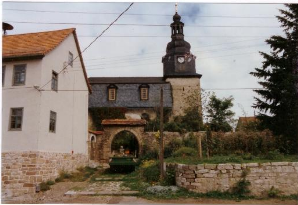
Angermauer (unten) und Eingangsbereich zur Kirche (oben) werden restauriert und befinden sich kurz vor der Fertigstellung.
