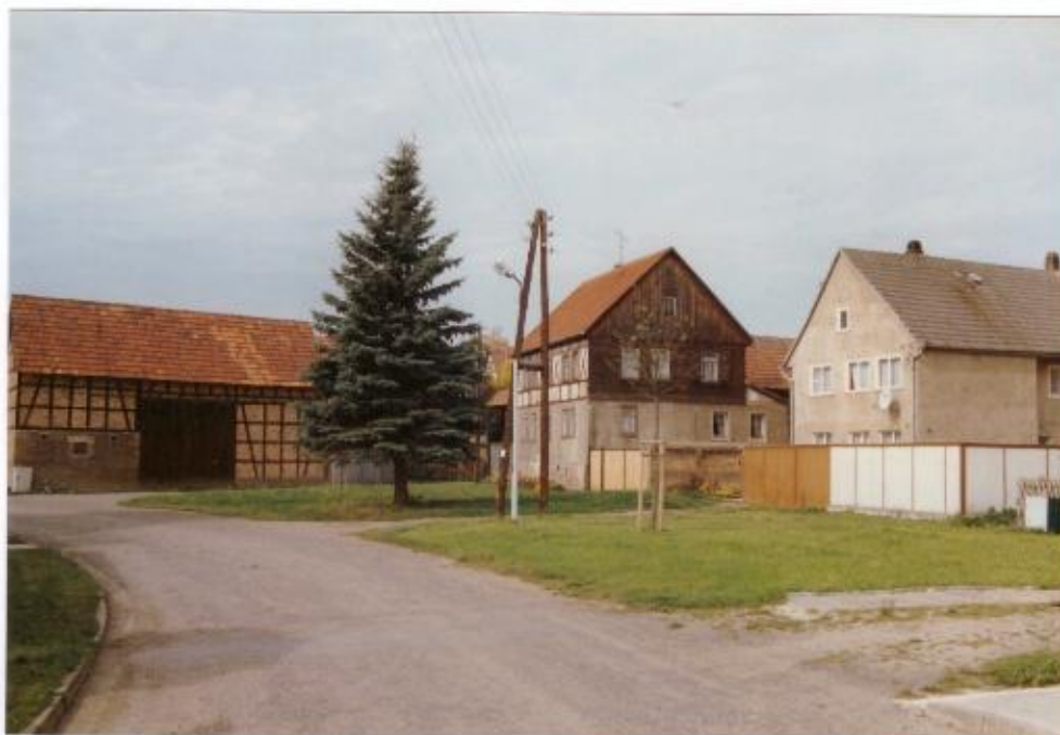
Oben: geplanter Ausbau als Platz im südlichen Dorfbereich mit Aufenthaltsmöglichkeiten.
