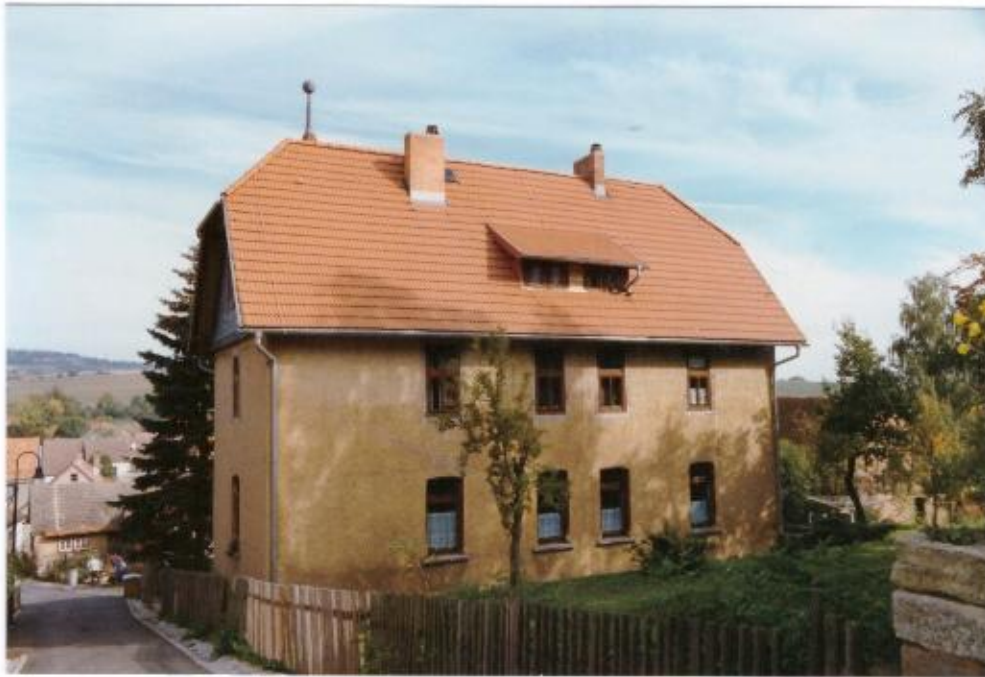
Dachsanierung des alten Pfarrhauses
