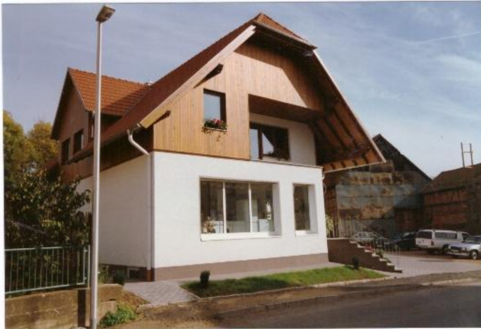
renoviertes Gebäude Elektrogeschäft
