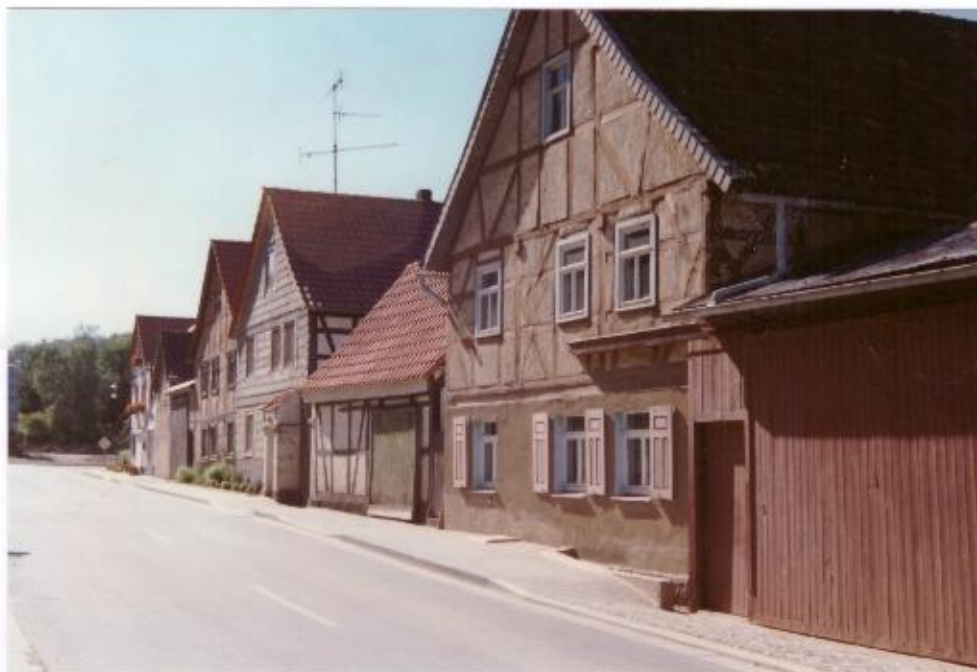
oben: Hauptstraße, Sicht Ost-West zum Teil freigelegtes Fachwerk an den Häusern; Dachsanierungen
