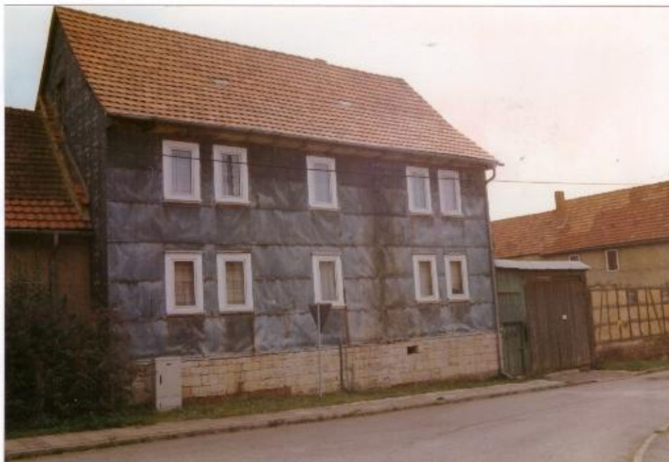
Eines von wenigen Beispielen nicht wünschenswerter Fenstererneuerungen. Außerdem ist die Verkleidung des Gebäudes im Gesamtbild störend.
