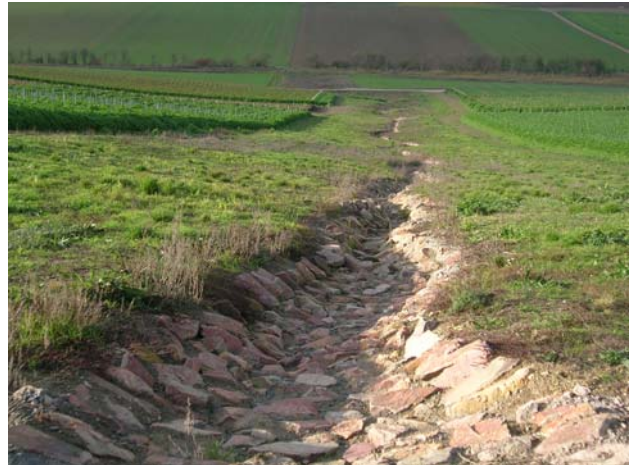
Abbildung 5-7: offener Entwässerungsgraben (Wißberg-Nord), Nov. 2005
