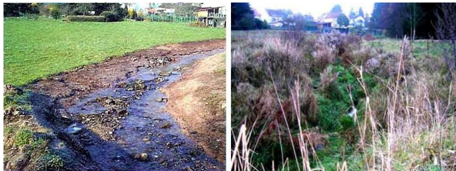
Abbildung 5-20: Entwicklung der Bachschleife links: Bauphase [DLR Westpfalz]; rechts: November 2005
