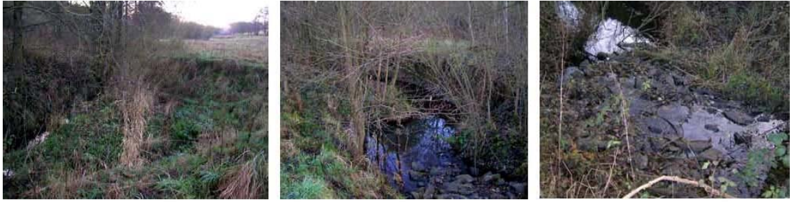
Abflachung u. Aufweitung des Ufers Eigenentwicklung durch Uferabbruch Sohle stabilisierung durch Schwellen
