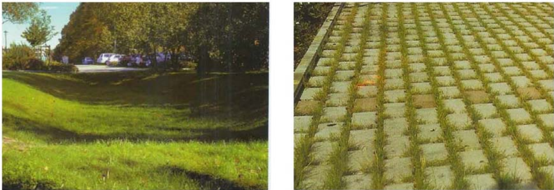
Abbildung 4-3: Parkplatzentwässerung über eine Mulde bzw. Rasenfugenpflaster [MfU-RP, 00]
