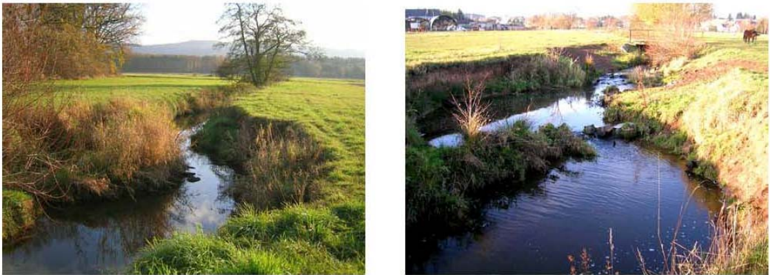
Abbildung 5-54: beginnende Auskolkungen und Uferabbrüche des Kohlbaches, November 2005
