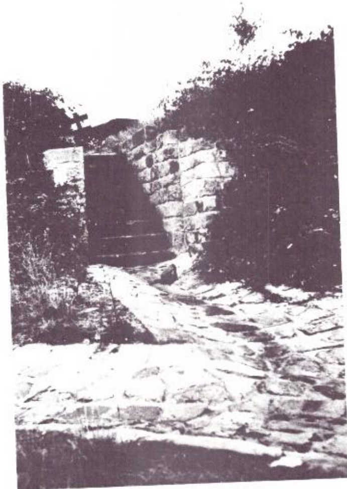
Bild 51 Treppe zur Regulierung des Wasserabflusses. Königsbach II
