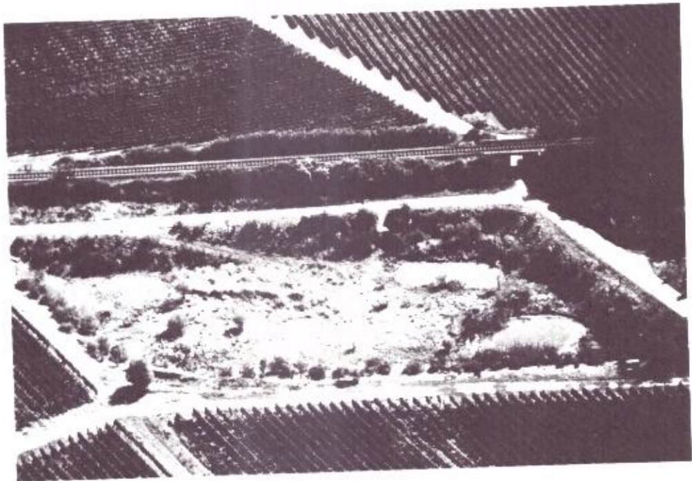
Bild 56 Wasserrückhaltebecken. Ruppertsberg II
