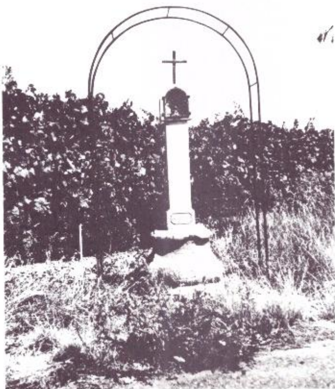
Bild 60 Denkmalsanierung. Königsbach II
