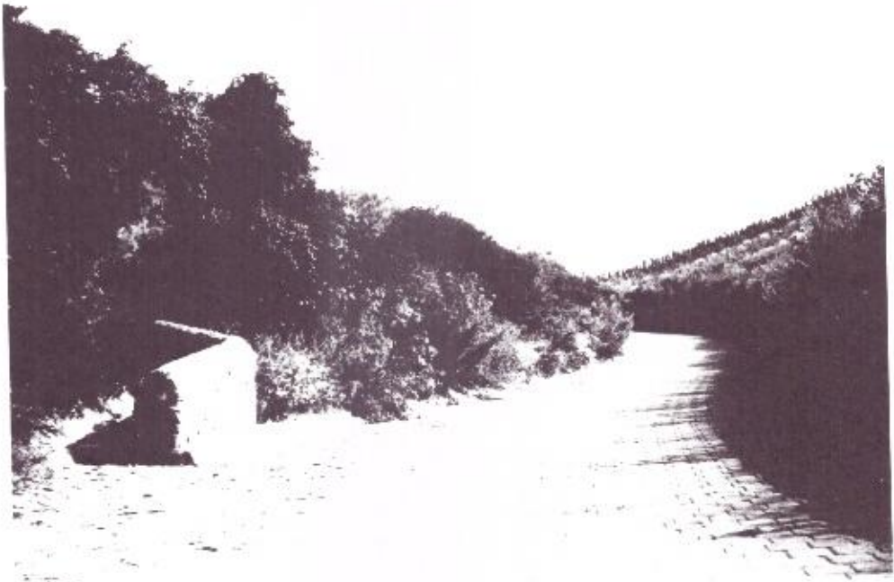
Bild 44 Geregelter Wasserabfluß im Hohlweg. Nierstein-Schwabsburg
