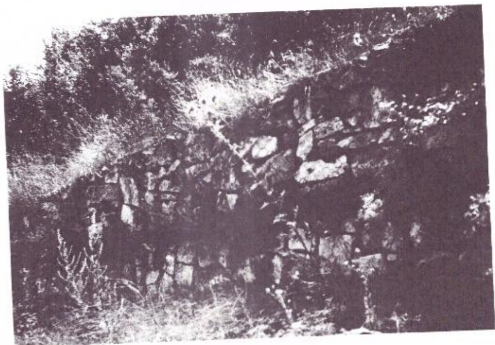
Bild 17 Gabionen mit Stützungsfunktion. Bornheim II
