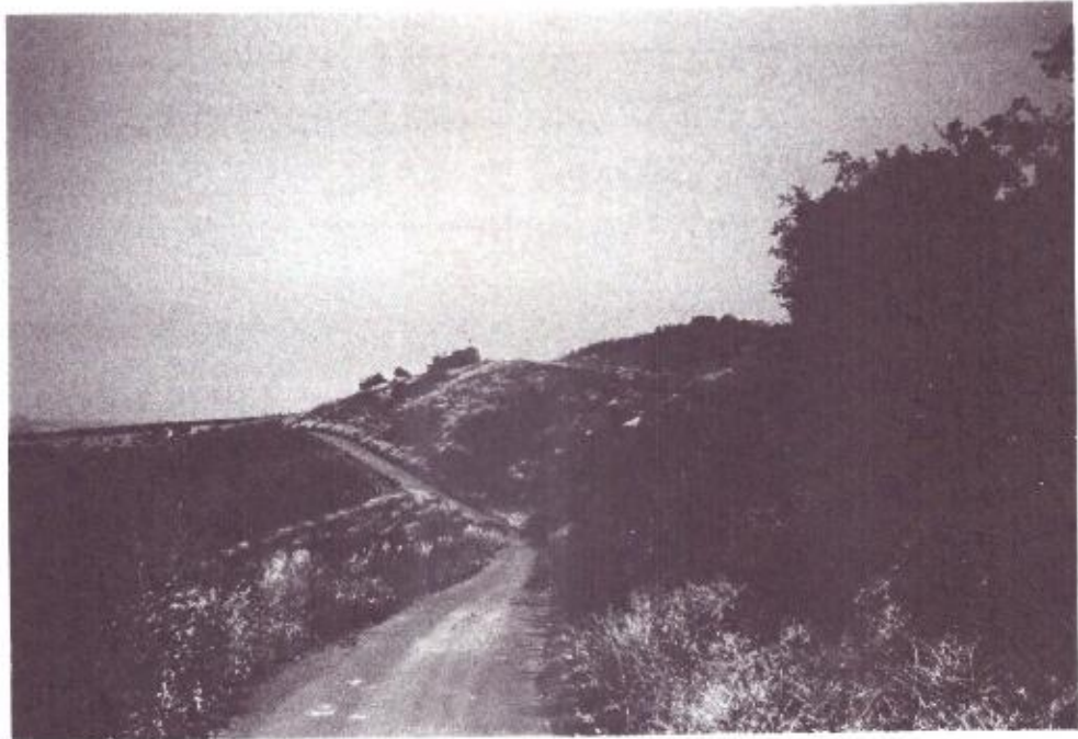
Bild 11 Erweiterung einer vorhandenen Böschung. Nierstein-Schwabsburg
