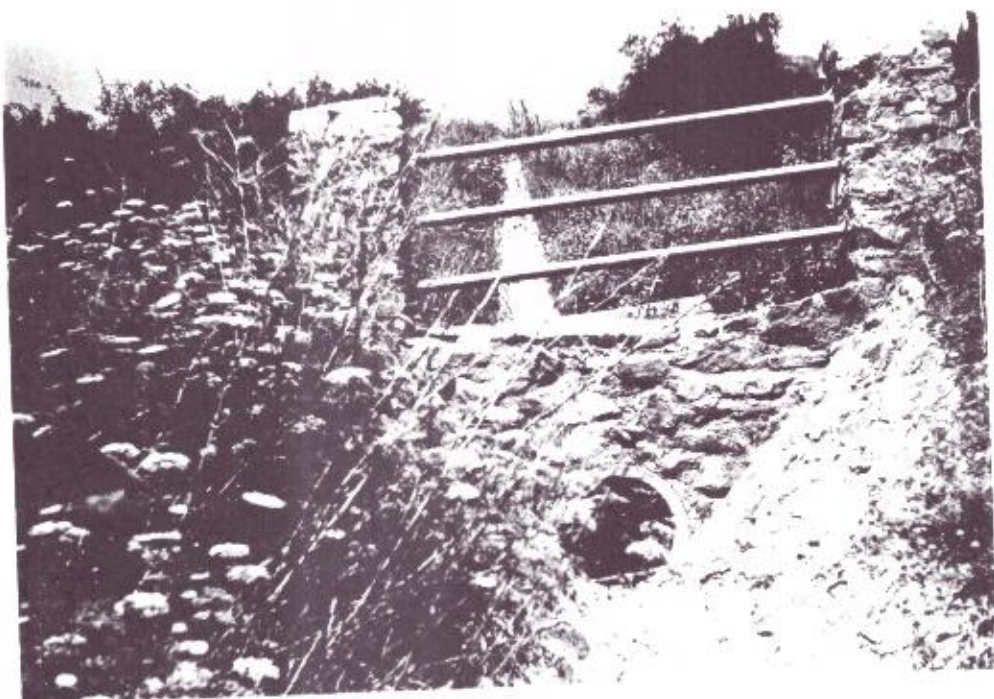
Bild 42 Naturnah ausgebaute Abflußrinne. Nierstein-Schwabsburg
