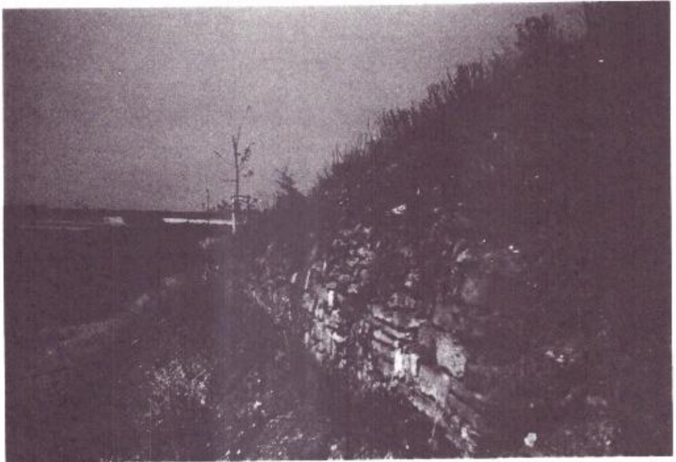
Bild 7 Einbindung einer vorhandenen Trockenmauer in eine neu aufgeschüttete Böschung. Nierstein-Schwabsburg
