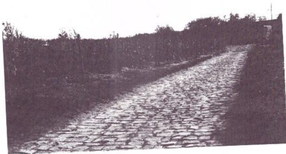
Bild 7: Alter Weg aus Pflastersteinen in der Gemarkung Bornheim/Rhh.
