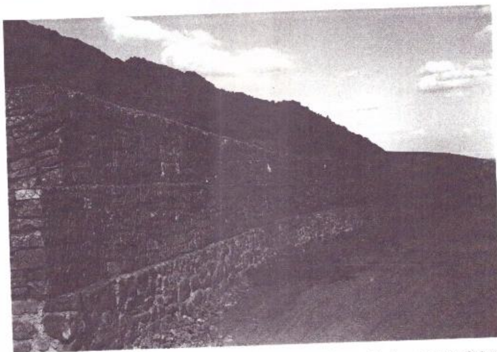
Bild 13: Gabionenmauerbau im Flurbereinigungsgebiet Nierstein/Rhh.
