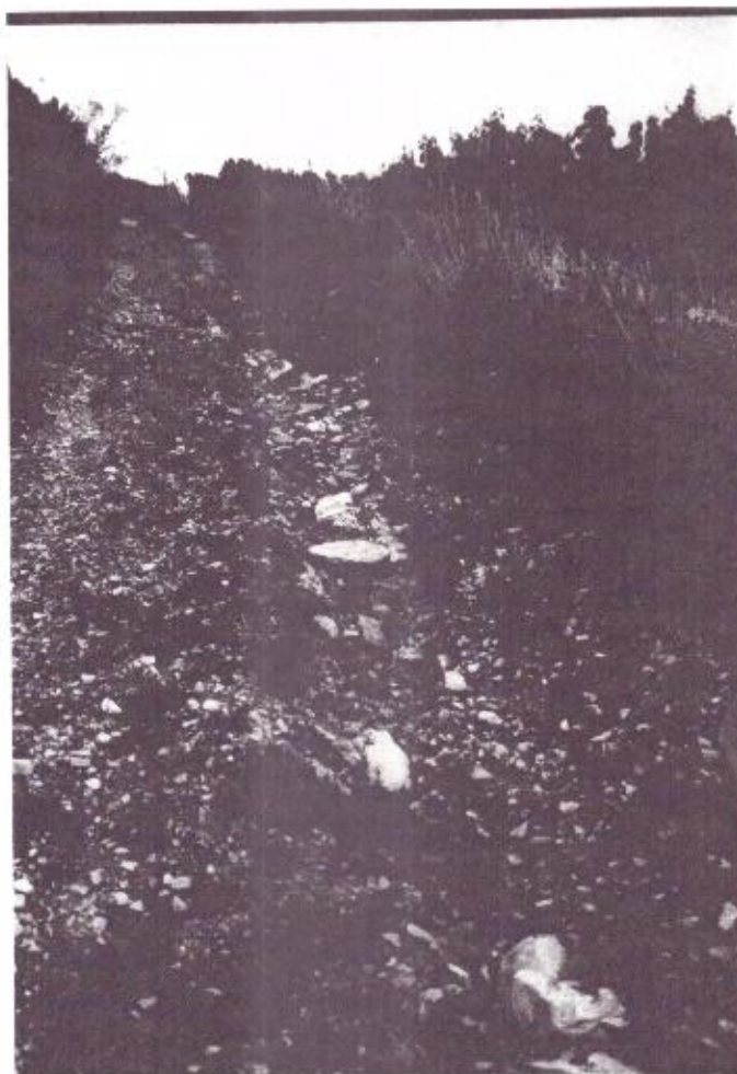
Bild 9: Ausschlemmung eines Weges in der Gemarkung Martinsthal/Rheingau
