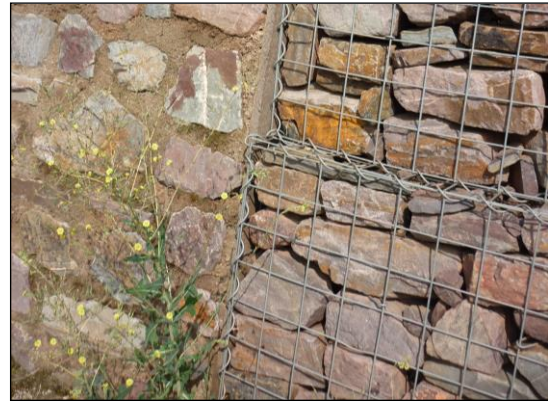
Abbildung 63: Fuge zwischen Mauer und Gabione 527
