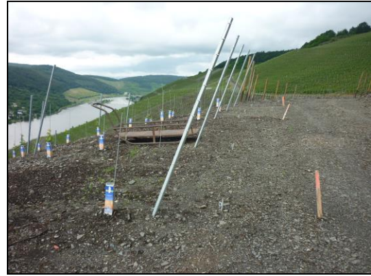
Abbildung 55: Anlage eines neuen Weinstocks 513
