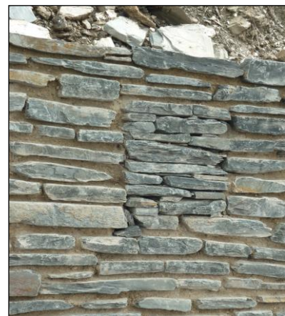
Abbildung 57: Mauer mit unverfugten Teil 515
