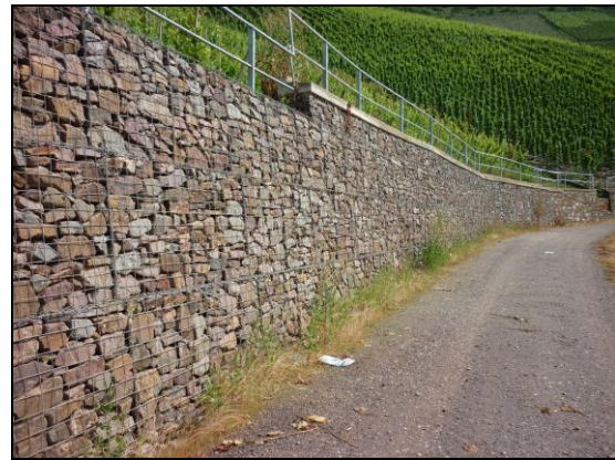
Abbildung 61: eher ungeeignete Gabionen 524
