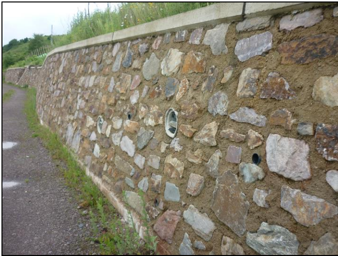
Abbildung 58: Mauer mit Rohren 517
