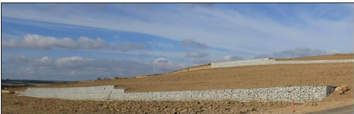
Abbildung 34: Ergebnis der Baumaßnahme
