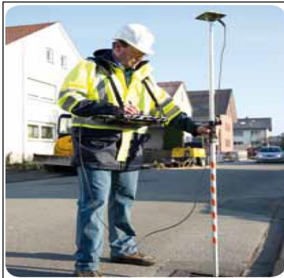
Abbildung 44: Einsatz mit Lotstabantenne 5
