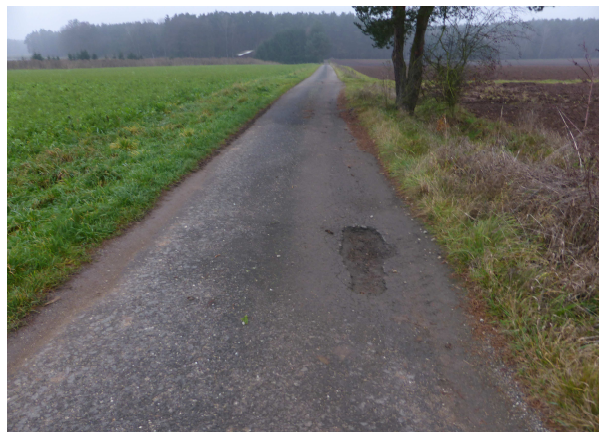
Abbildung 3.2: Schlagloch in Asphaltdecke
