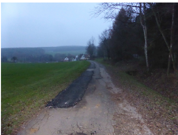
Abbildung 3.1: Asphaltabbruch am Wegrand
