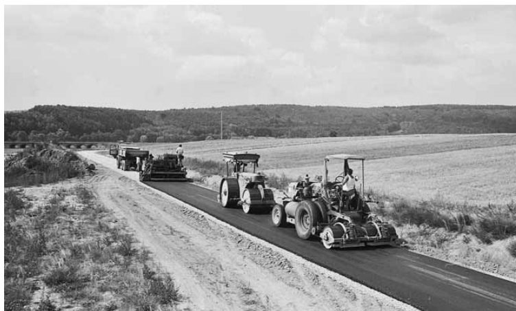
Abbildung 2.3: Wegebau in den 1970er- Jahren in Unterfranken (Richter, R / Zedler, J: 50 Jahre Verband für Ländliche Entwicklung Unterfranken (2010) S. 37)
