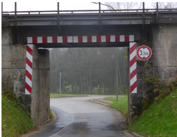
Abbildung 6.1: Bahnunterführung Höhe = 3,30 m
