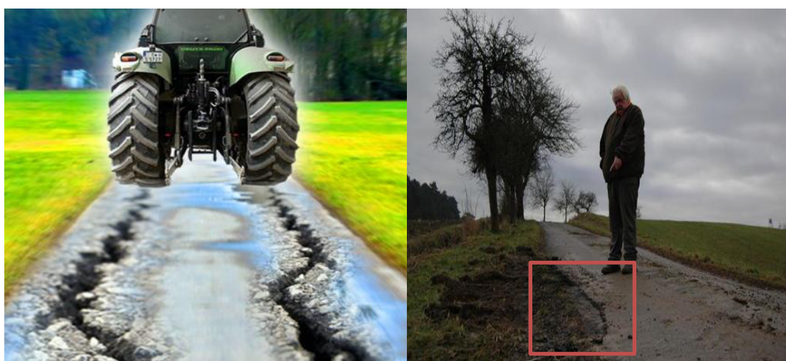
Abbildung 3 und 3.1: Schäden, die durch zu hohe Wegebelastung entstehen (Quelle 3: Matthias Feuerer, Quelle 3.1: Matthias Mayer)
