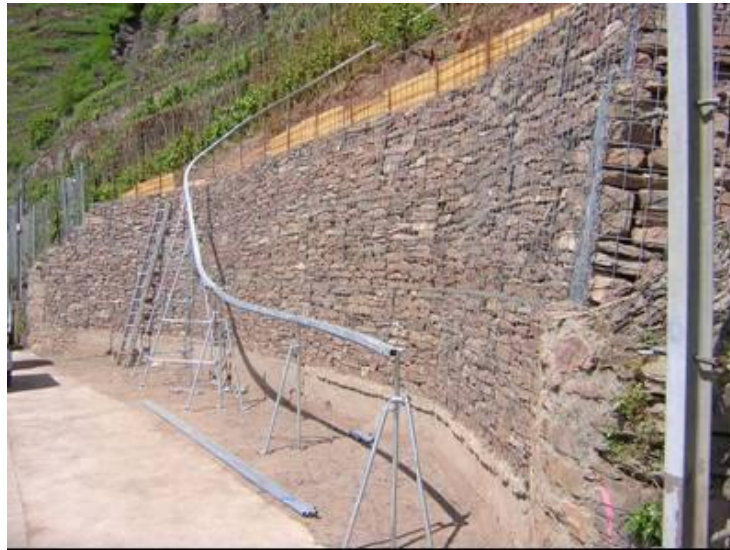
Abbildung 24: Gabionenmauer am Bahnhof des Erschließungsbeispiels 5.1
