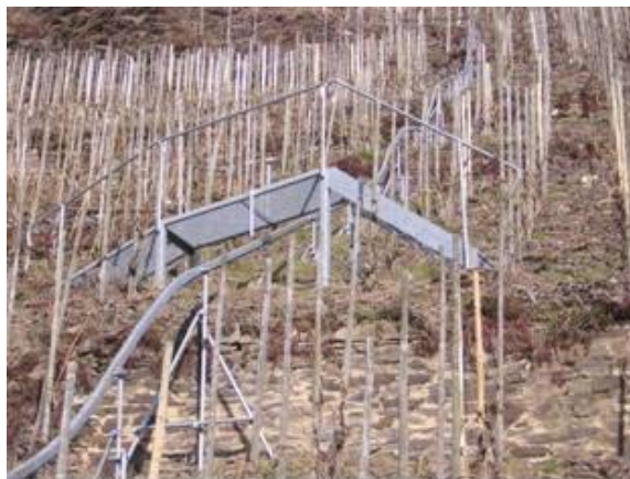
Abbildung 7: Brücke über Schiene mit Abschaltvorrichtung
