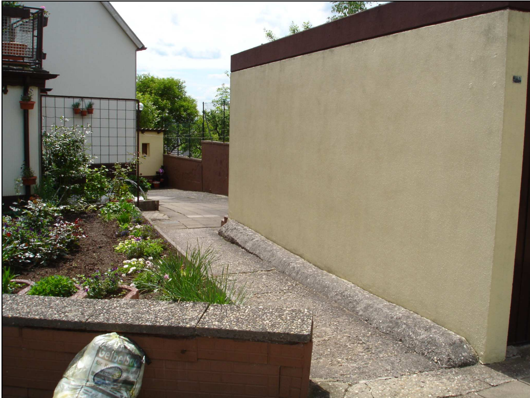
Abbildung 16: Foto 1 zu Beispiel 5 (Blick von Straße aus auf Flurst. 81)
