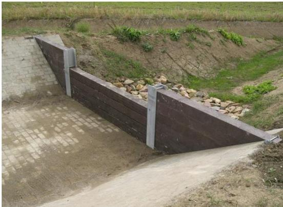
Abbildung 24: Schlammfang - Rückhaltebecken
