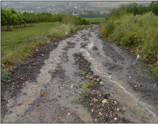
Abbildung 22: Erosionsschaden am Weg
