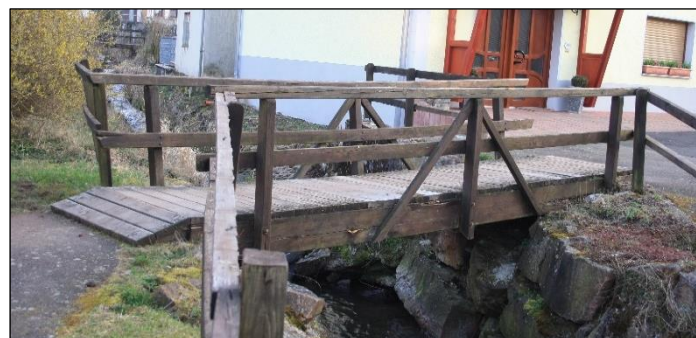
Abbildung 84: Alte Brücke über den Bornbach
