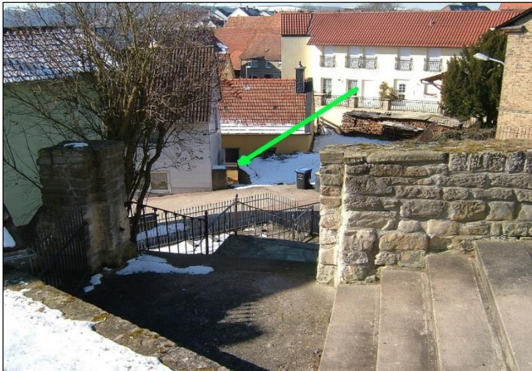
Abbildung 24: Blick von der Kirche auf den Hinterausgang des Hauses [Quelle: DLR RNH]
