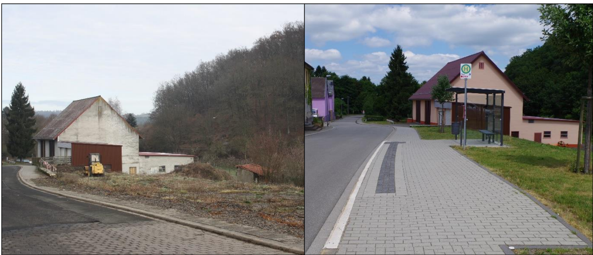
Abbildung 90: Kreisstraße Ortseingang Berschweiler vorher – nachher [Quelle: OB a.D. Peter Becker und eigene]
