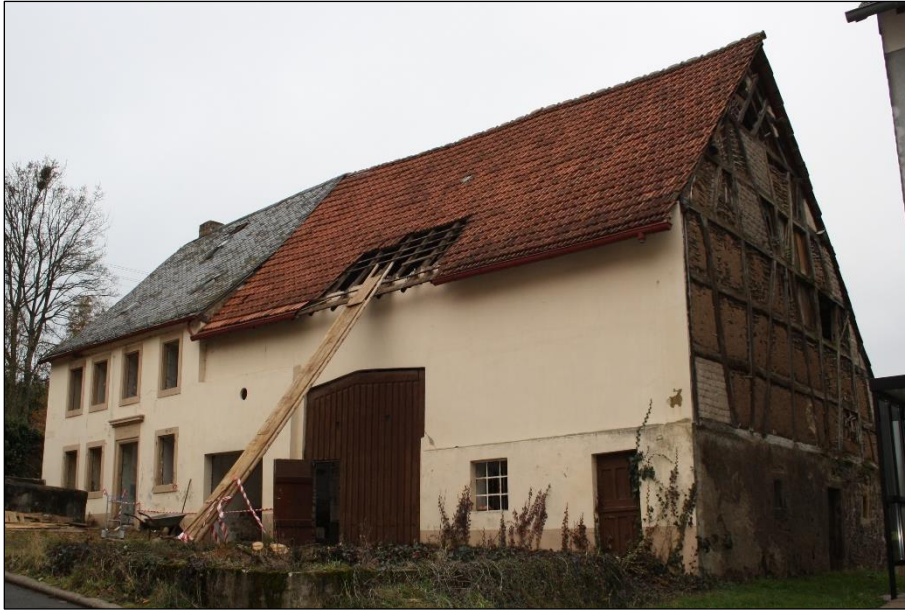
Abbildung 69: Einfirsthof mit beschädigter Giebelwand [Quelle: Siegfried Henn TG]
