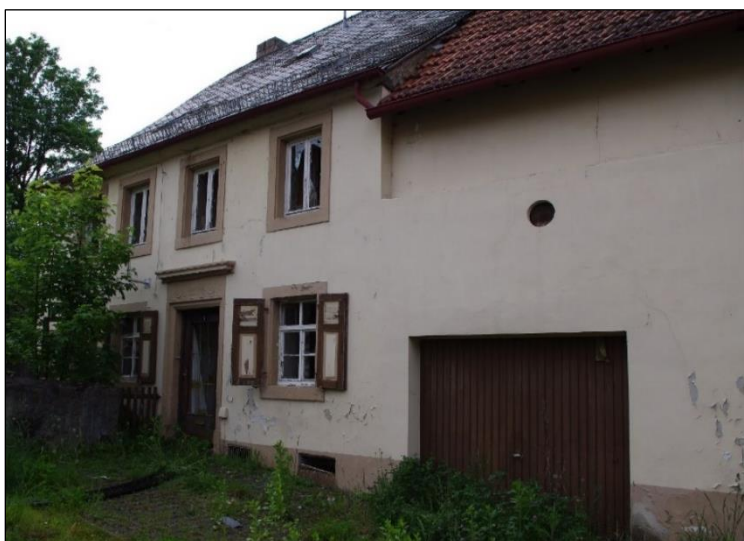
Abbildung 68: Zerstörte Fenster und Türen [Quelle: Siegfried Henn TG]
