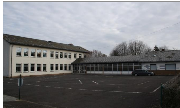
Abbildung 97: Ehemalige Grundschule [Quelle: Eigene]
