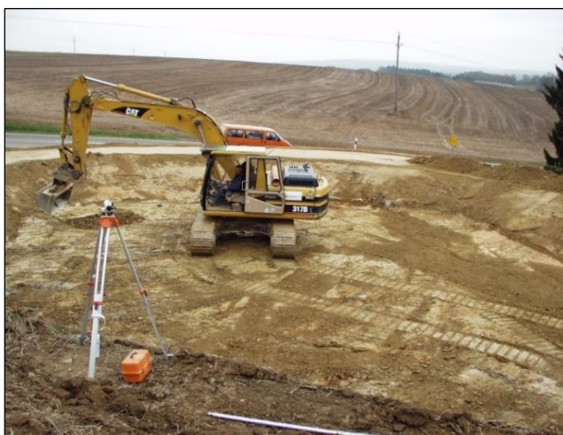
Abbildung 32: Bau eines Rückhaltebeckens
