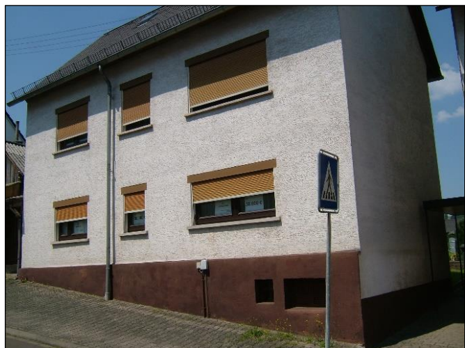
Abbildung 15: Abrisshaus [Quelle: DLR RNH]
