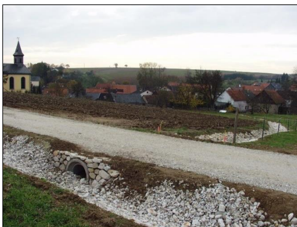
Abbildung 30: Errichteter Graben [Quelle: DLR RNH]
