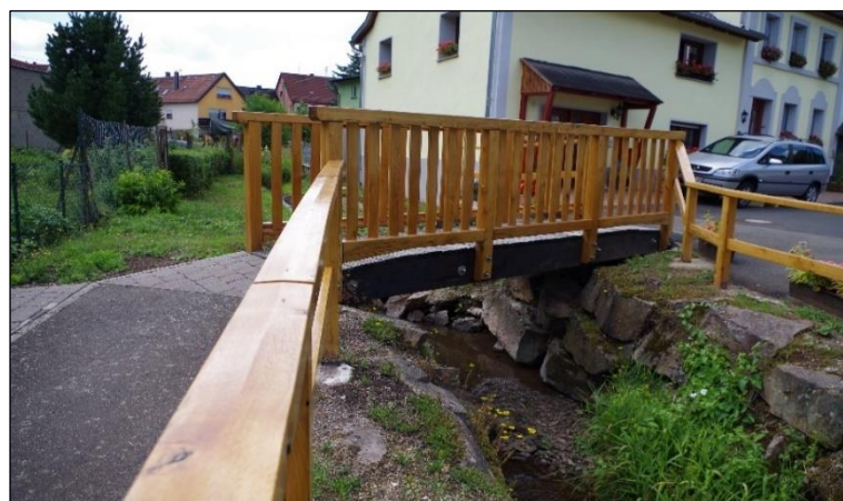
Abbildung 87: Neue Brücke [Quelle: Eigene]
