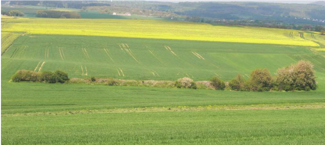
Abbildung 14: Kontrollierte Böschung Berresheim
