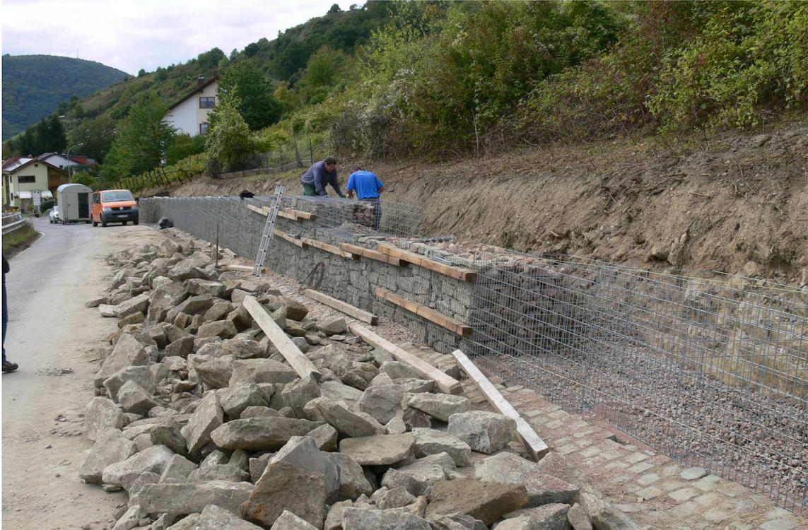
Abbildung 40: Bau einer Stützmauer in Gabionenbauweise im Verfahren Niederhausen
