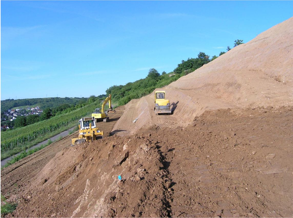
Abbildung 36: Bau der Querterrassen im Verfahren Münster-Sarmsheim
