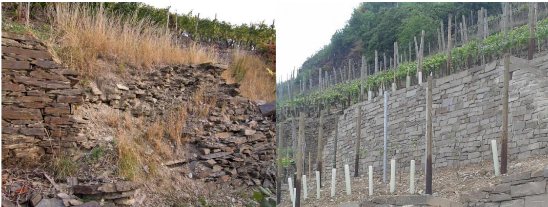
Abbildung 1: Beispiel einer Mauersanierung (Jacoby, 2014)
