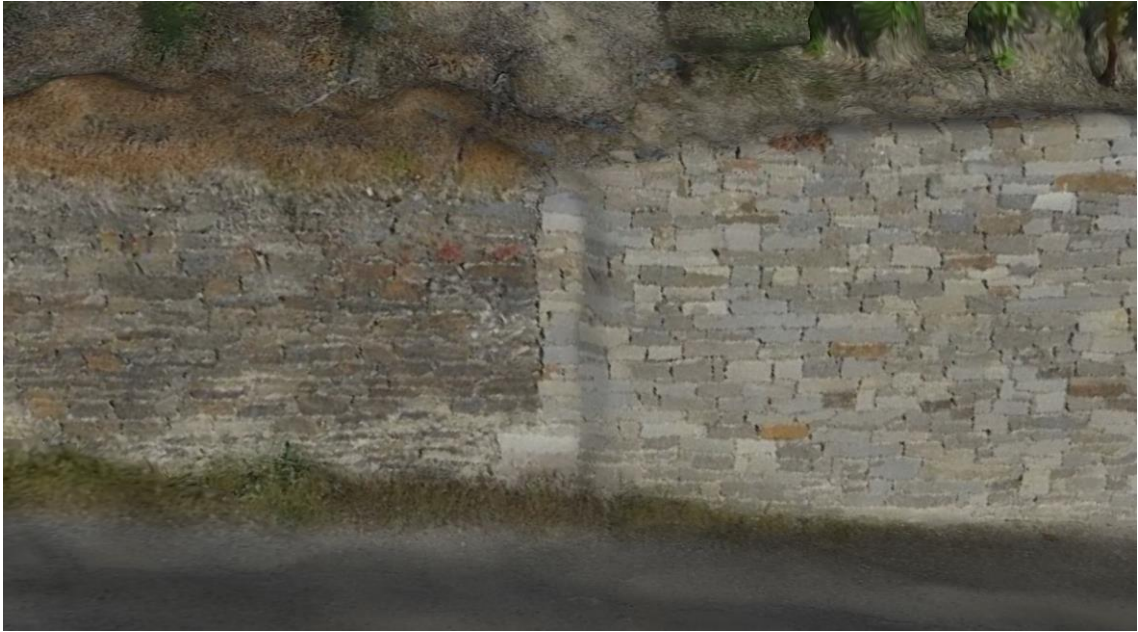
Abbildung 63: Vergleich zwischen alter (links) und neuer Weinbergsmauer (rechts)
